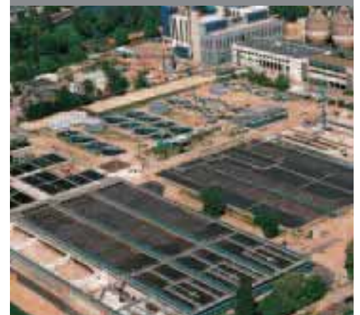
Sewage treatment plant Berlin pour stations d'épuration Berlin
