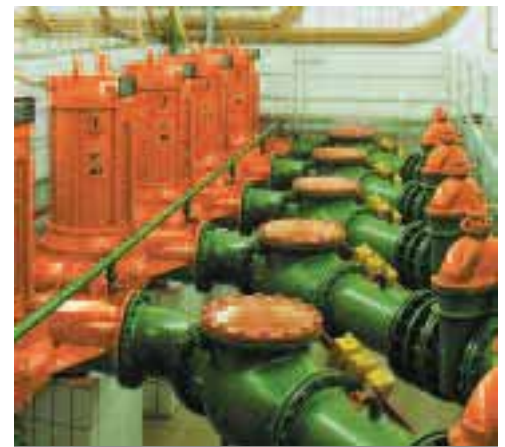
Dry sump installation Montage à sec
