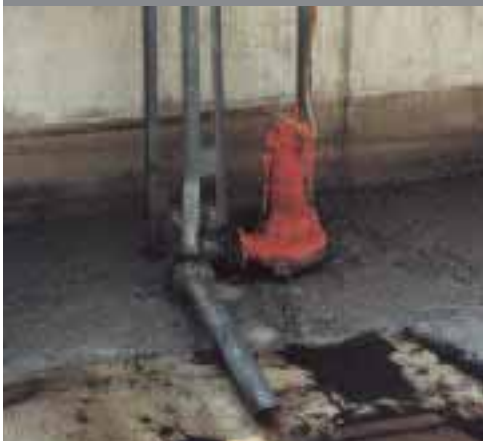
Cleaning of storm water retaining basins Nettoyage des bassins à eau pluviale
