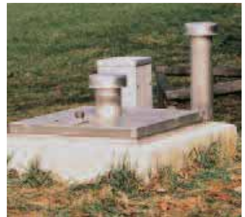
Well cover, vertical well at territory Cabeza de pozo, pozos verticales en el campo
