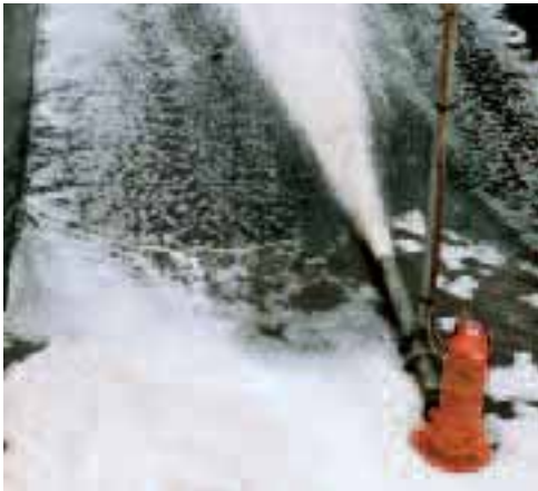
Cleaning directly at the tank bottom Nettoyage directement au fond de bassin
