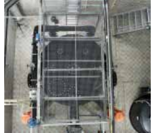
PEHD pumping station with working platform Station de pompage PEHD avec plateforme de travail
