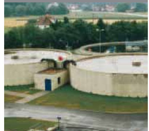
Pumping of sewage containing nitrate Pompage d'eau résiduaire contenant du nitrate
