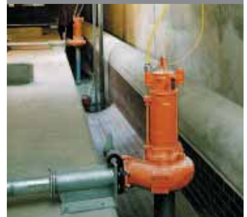
Application in rain overflow tank Application d'eau bassin de débordement d'eau pluviale
