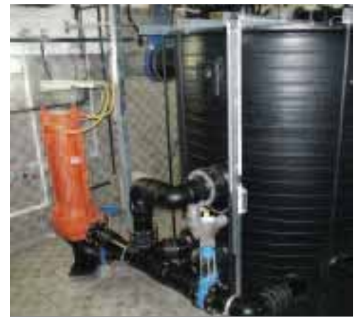
PEHD-collection réservoir with one pump Réservoir collecteur PEHD avec une pompe
