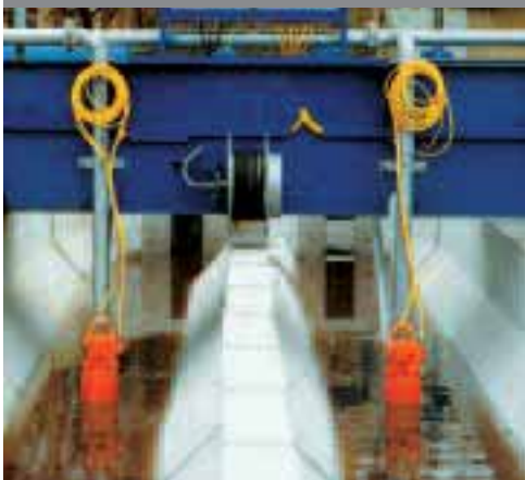
Grit collector with Wilo mixer heads Dessableur avec têtes d'émulsion Wilo
