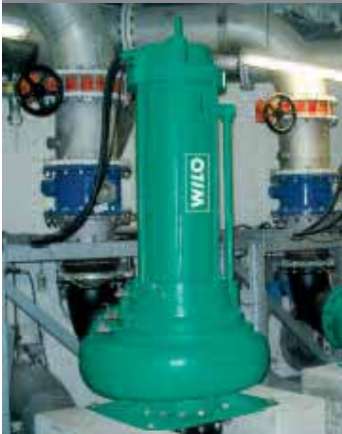
Dry sump installation Montage à sec
