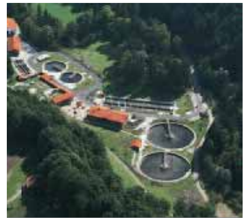
Sewage treatment plant Selbitztal pour stations d'épuration Selbitztal
